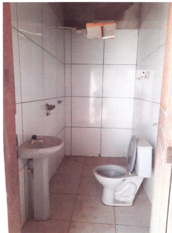
Figura 14: Banheiro com revestimento até 2,00m altura.
