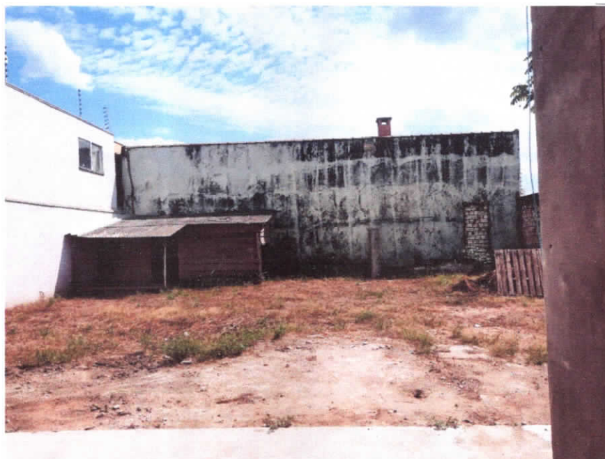
Figura 17: Área externa do imóvel
