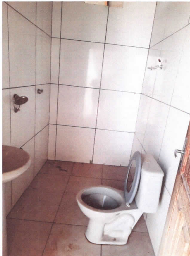
Figura 13: Banheiro com revestimento até 2,00m altura.
