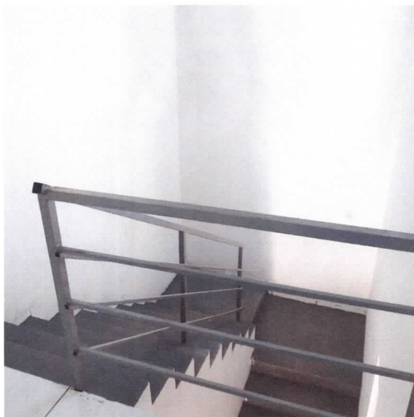
Figura 7: Escada e corrimão
