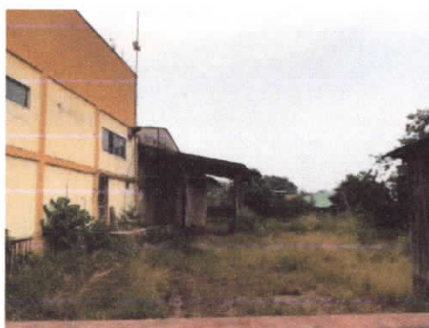
Figura 2 – Vista do Logradouro
