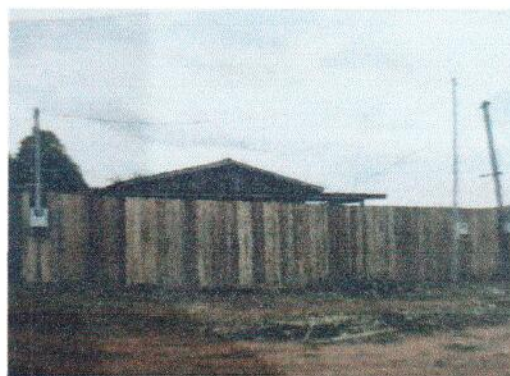
Figura 2 – Vista do Logradouro
